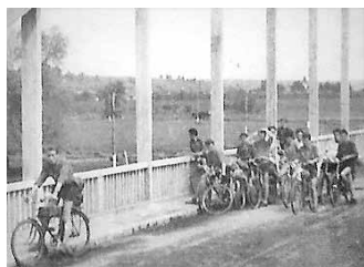
Die Brücke über den Alt bei Voila, Jüstel vorneweg
